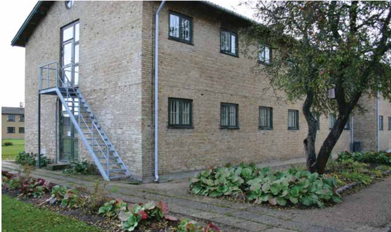
Afdelingen for sexkriminelle er placeret i bygningens stueetage.
