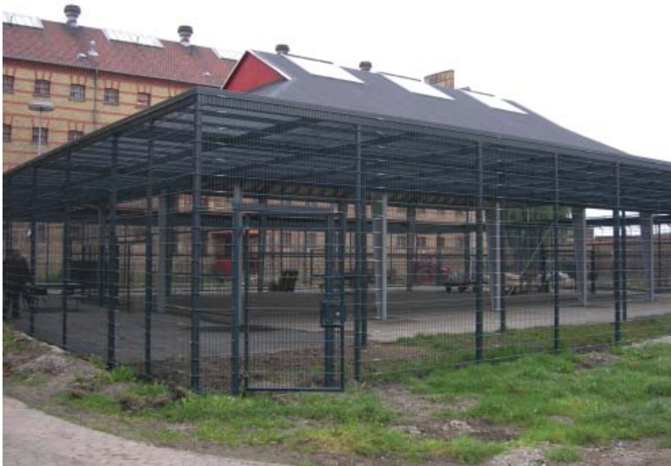
Overdækningen af Østfløjens gårdtursareal blev færdig i oktober.
