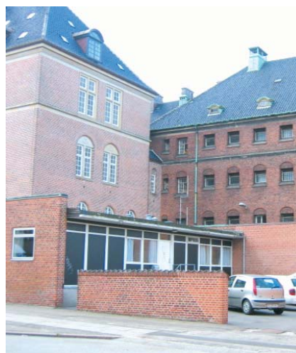
Medarbejderne i Arresthuset i Århus har i løbet af sommeren tilføjet to nye befolkningsgrupper på risikolisten: Bløde trafikanter og besvimelede arrestanter.
