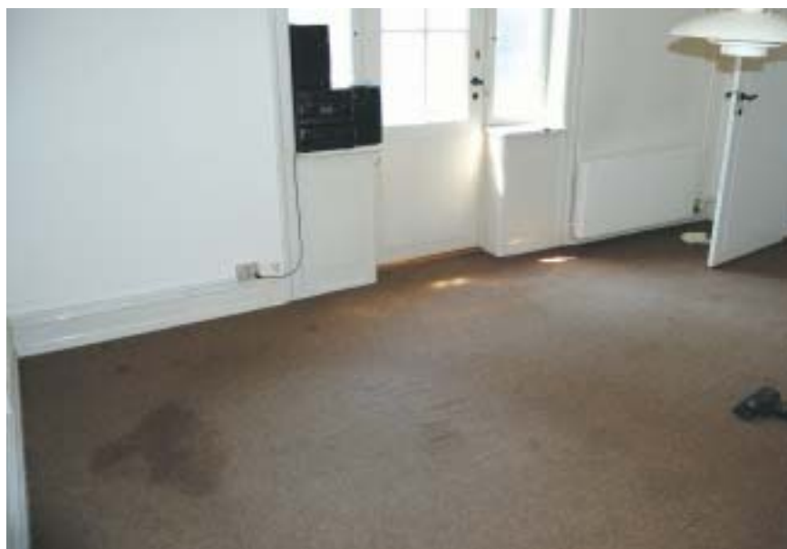
Et tæppe i boligen, der er hårdt ramt af pletter og skjolder.
