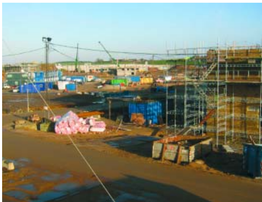
En af danmarks største byggepladser.
