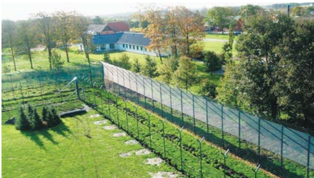
For at sikre de nye arresthuspladser er der opsat hegn. I baggrunden ses administrationsbygningen og dele af den åbne afdeling.
